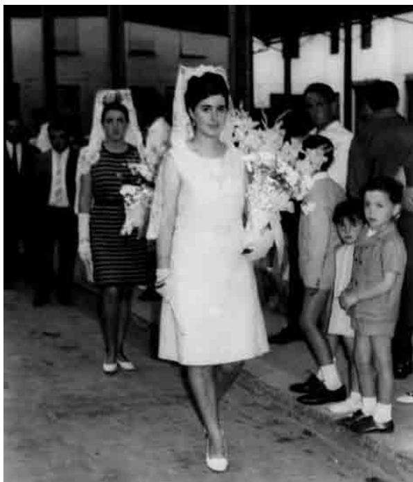
En esta fotografía se pueden ver los pilares de hierro y un poco de la uralita del techo del mercado.
