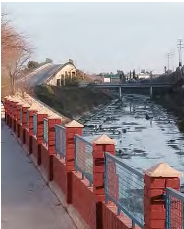
▲ Antic Pont de FERRO
