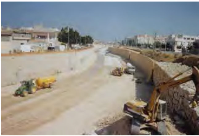
▲ Obres d'ampliació del BARRANC
