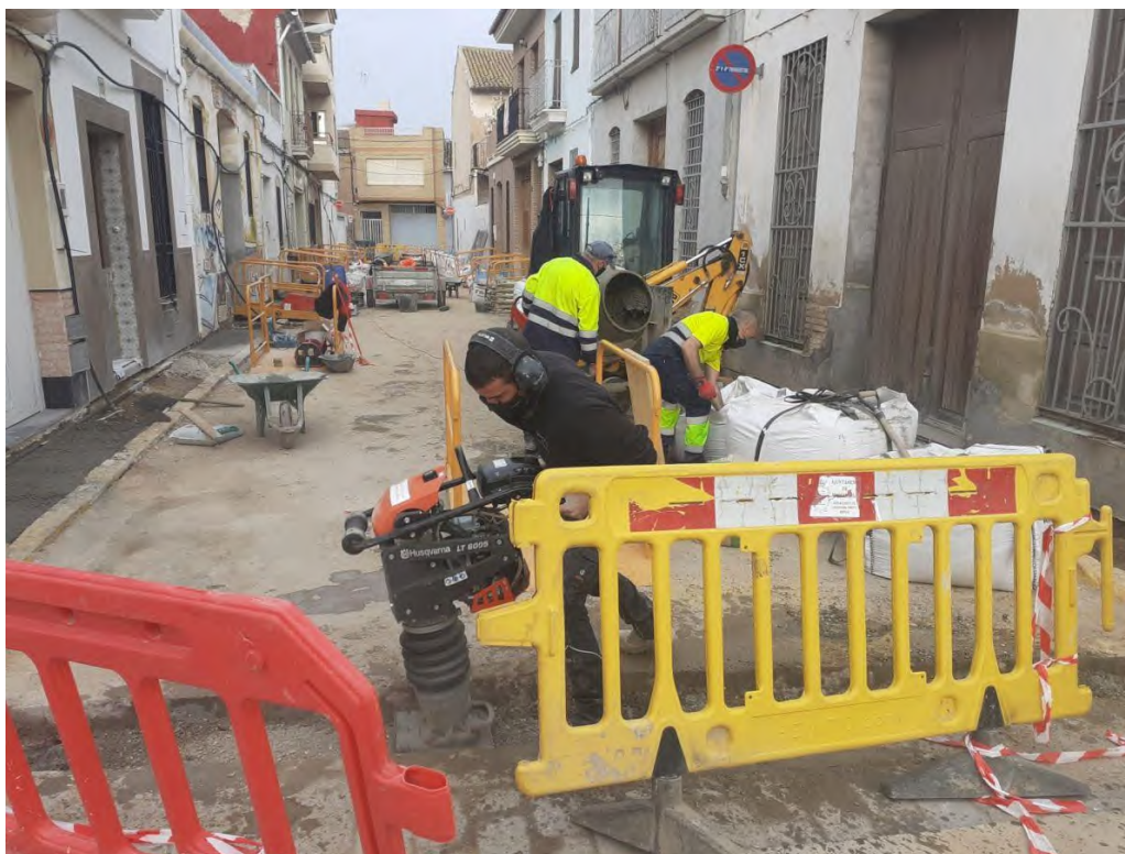
ILUSTRACIÓN 32. RENOVACIÓN ACERAS MASSANASSA
