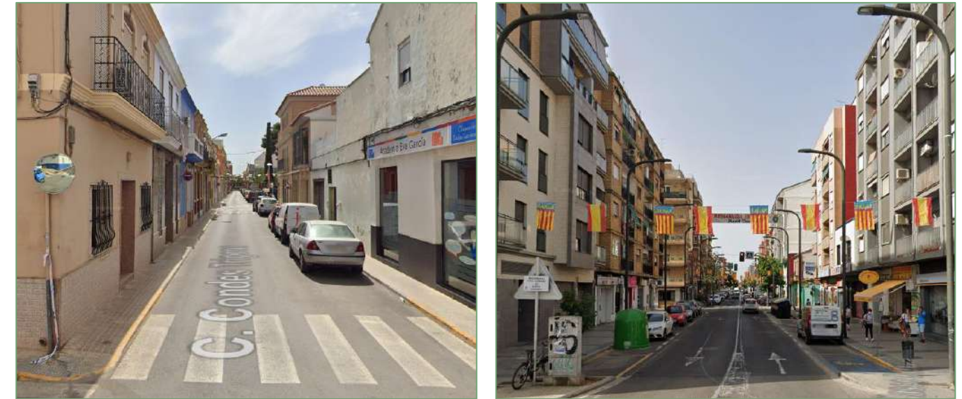
Ilustración 31. Aceras estrechas (c. Condes Trigona) y aceras accesibles (c. Blasco Ibáñez)
