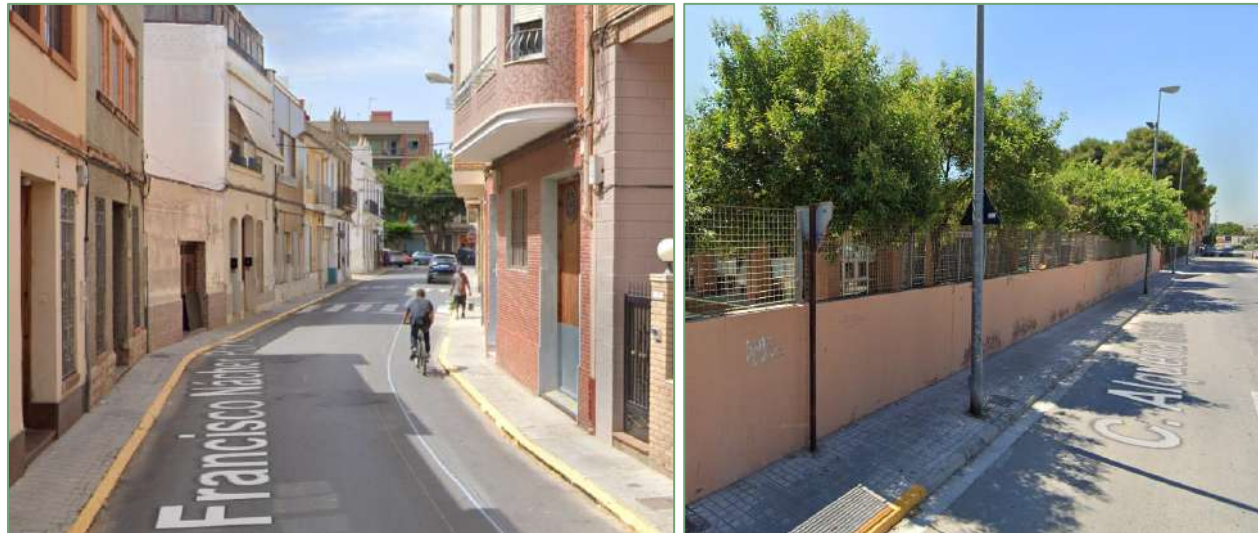
Il·lustració 39. Ancho de acera insuficiente (c. Francisco Nácher Pons y c. Alquería Soria)
