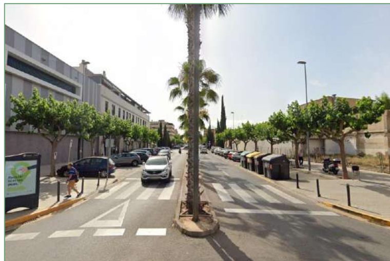
Ilustración 30. Calle con acera y calzada (Av. Alba I Alba)
