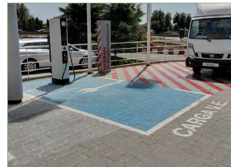
Il·lustración 69. Punto gratuito de recarga de vehículos eléctricos
